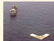
2000・5 隅角部ケーソン据付
