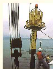
1999・7 工事着手(灯標設置)
