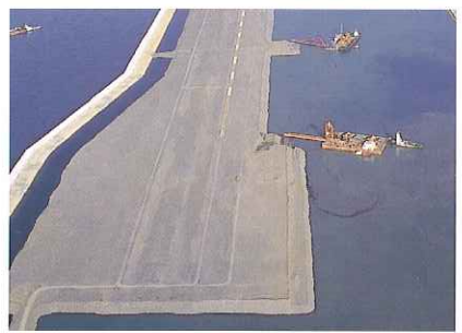
揚土船で盛土
