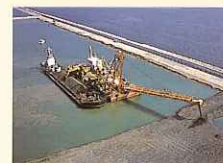
2002・5 揚土①工事開始
