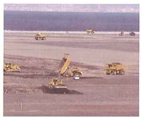
運搬・敷均し
