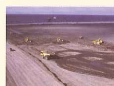
2003・11 揚土②工事開始
