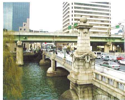
現在の難波橋
