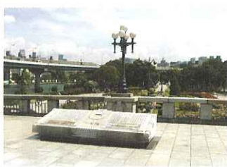
難波橋のバルコニー
